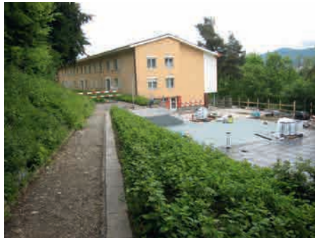
Auf der Garage wird der Kinderspielplatz mit Sandkasten, Rutschbahn, Schaukel und diversen Sitzbänken entstehen.
