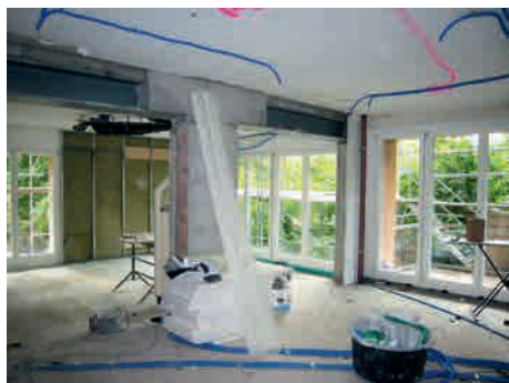
Im neuen Gemeinschaftsraum sind schon die Fenster eingebaut.
