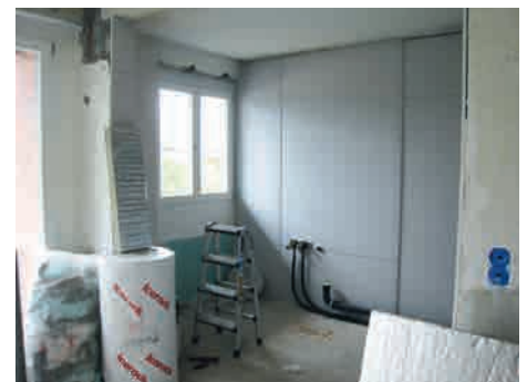
Hier wird die neue Küche entstehen.
