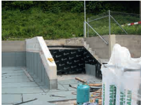
Hier entsteht die neue Treppe mit Kinderwagenrampe auf den Spielplatz.
