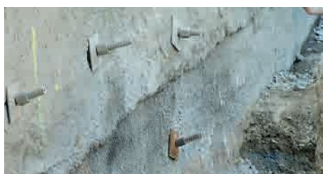
Dies sind die Erdanker welche das bestehende Gebäude im Untergrund stabilisiert.
