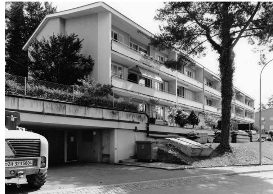
Durchlaufende Loggien und asymmetrisches Satteldach: Winzerhalde 72, 74, 76 während der Bauarbeiten von 2010 bis 2013. Baugeschichtliches Archiv Stadt Zürich, Foto: Hanspeter Dudli, 2011
