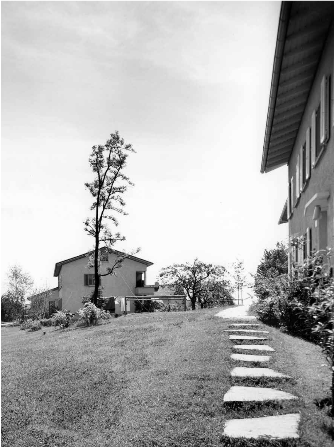
Zwischenbächen: besonnte Wohnräume und leicht zugänglicher Aussenraum. Baugeschichtliches Archiv Stadt Zürich, Foto: Michael Wolgensinger, ohne Jahr (vermutlich 1953)
