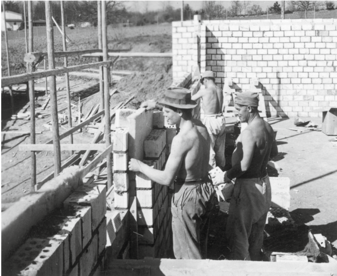
Doppelt gemauerte Aussenwände senken den Energieverbrauch. Baustelle Siedlung Höneggerberg 1953/54. Archiv bgnzwo
