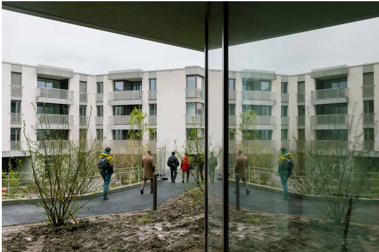
Ein bestehender Fussweg unterteilt die alte und neue Siedlung in zwei Bereiche und den Bauablauf in zwei Etappen.
